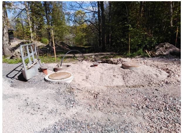
Kunnallistekniikkaa on rakennettu. Kuva Viherlaakson Kuusiniemestä.
